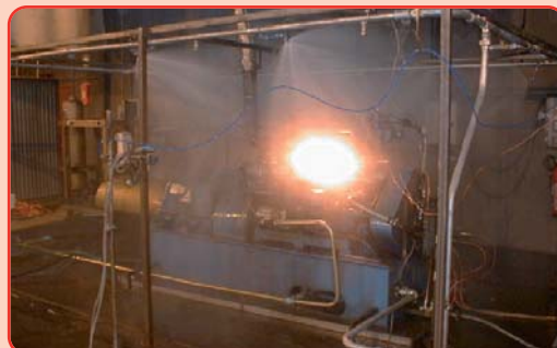
Local hydraulique – groupe électrogène
